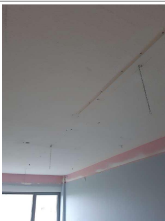
Prélèvement - P023 : Bâtiment E / R+1 / Sanitaires 3 - Enduit projeté- (Présence d'amiante)
